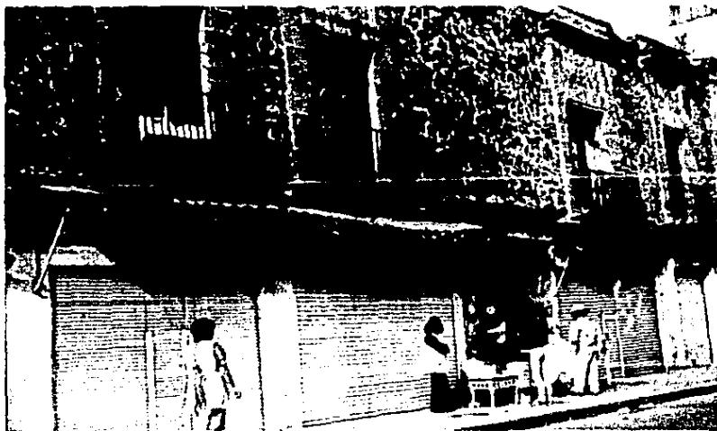
2.- ASPECTO ACTUAL DE LA FACHADA.
