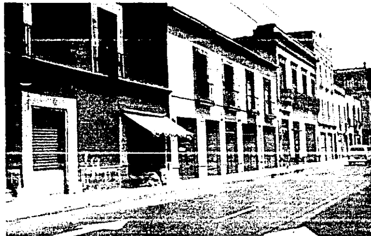
24. CALLE REPUBLICA DEL SALVADOR . FACHADAS NORTE
