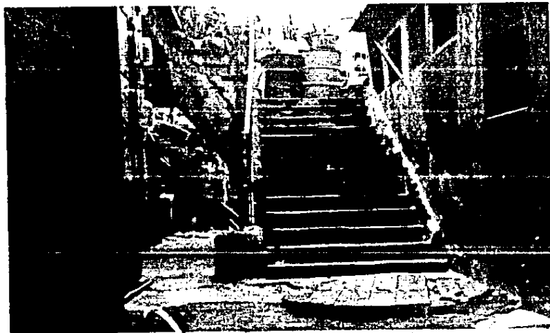
4. VISTA DE LA ESCALERA
