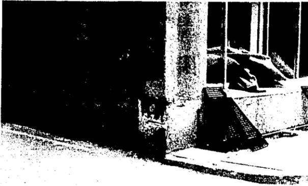
FOTOGRAFIA 4. PANDEO DE VARILLAS LONGITUDINALES, EXTREMO INFERIOR DE COLUMNA EXTERIOR, EJE 1, EDIFICIO LM10-02.
