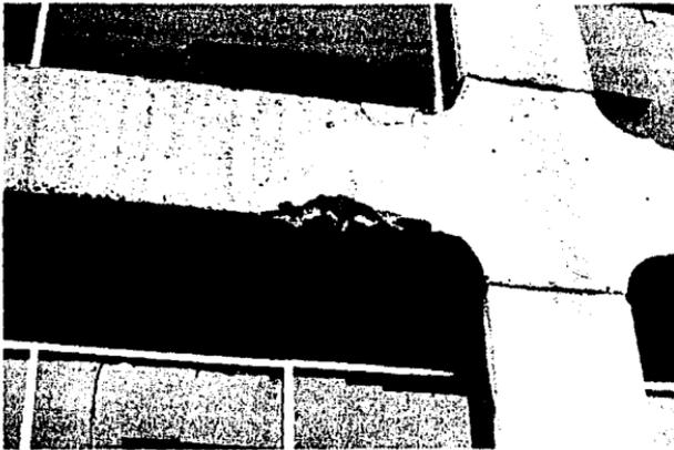
FOTOGRAFIA 6. VISTA EXTERIOR DE FALLA TIPICA EN EXTREMOS DE VIGA.
