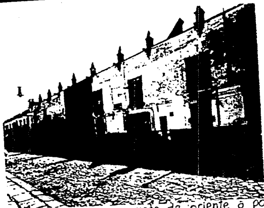
Pensador Mexicano, vista de oriente a poniente (edificaciones ya demolidas)
