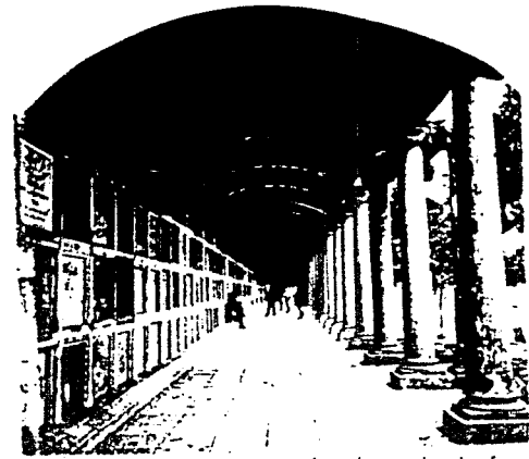
Panteón de Santa Paula, antes de su demolición
