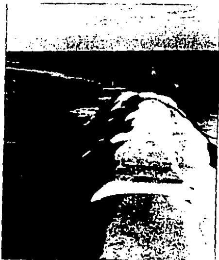
Fig. 11. 20 APLICACION DE GEOTEXTIL COMO CONTENEDOR DE RELLENO HIDRAULICO EN PROTECCION DE COSTAS (Ref. No. 63)
