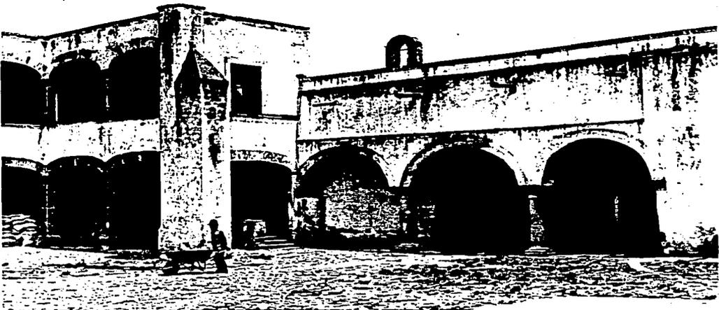
Columnas en cantera, contrafuertes en piedra y arcos en aparejo de ladrillo en la casa del
