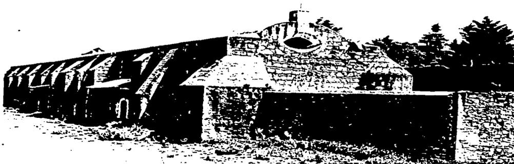
Muros, contrafuertes y bóveda de cañón en cantera, Troje de la HACIENDA DE MAZARRAZA,
