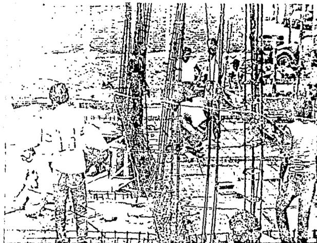
TENDIDO DEL ACERO PARA LAS CIMENTACIONES DE LAS 1ª A VIVIENDAS Y ANCLAJE DE CASTILLOS EN LA CIMENTACION.
