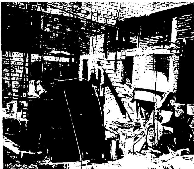
EL ALUMNO JOSE OSCAR MENDOZA SUPERVIZANDO QUE EL TABIQUE ROJO RECOCIDO PARA EMPLEARSE EN EL DESPLANTE DE MUROS DEL SIGUIENTE BLOQUE DE CASAS, ESTE PERFECTAMENTE HUMEDECIDO, Y EN BUENAS CONDICIONES YA DESPLANTADOS LOS MUROS SE CHECA QUE ESTEN A PLOMO Y EL ACABADO SERA APARENTE.
