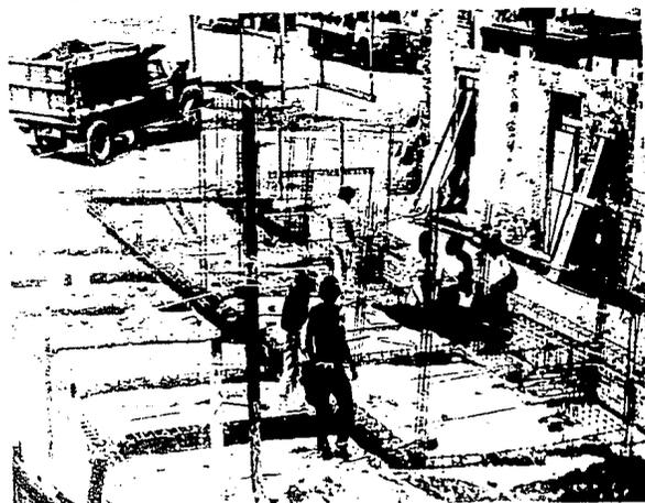
DETALLE DE ARMADO DE LOSA DE CIMENTACION Y DESPLANTE DE CASTILLOS EN BLOQUE DE LAS PRIMERAS
