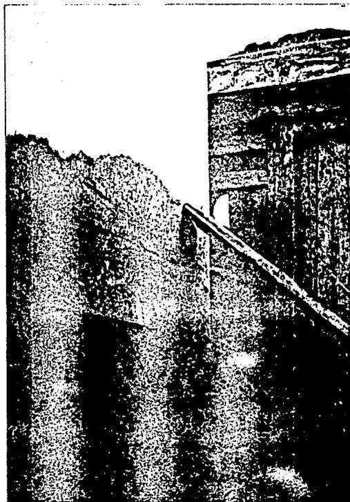
VISTA DEL COLADO DEL MURO CON METAL DESPLEGADO.
