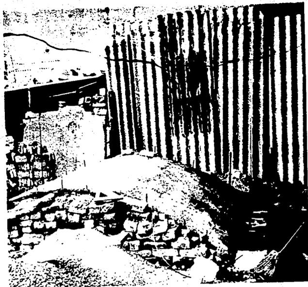
MOLDE HECHO DE TIERRA CON UNA CAPA DE 3CM. DE CONCRETO PARA HACER DOVELAS DE TABIQUE ARMADO.
