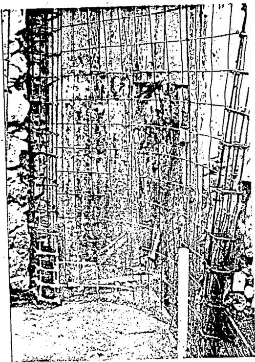
DETALLE DEL ARMADO DE MURO CURVO CON MALLA 6X6 10/10 Y METAL DESPLEGADO EN ZONA DE SERVICIOS.
