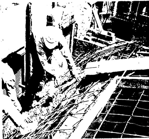
COLADO DEL GRAN GALPON USANDO UN, CONCRETO F'C= 200 KG. CM2 Y UNA PROPORCION DE 1:2:3 y 39 L.T. POR 1 SACO DE CONCRETO, Y UN REVENIMIENTO DE 6 CMS. YA QUE NO SE UTILIZA CIMBRA DE MADERA Y EL CONCRETO LO RECIBE EL METAL DESPLEGADO QUE VA POR DEBAJO DE LAS VARILLAS Y AMARRADO A ESTAS.
