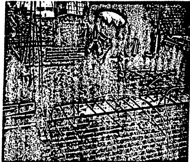
ARMADO Y COLOCADO DE LOSA PLANA EN LA ZONA DE SERVICIOS ( COCINA, BAÑO ) DEJANDO LAS PREPARACIONES DE LA INSTALACION ELECTRICA, UTILIZANDO UN CONCRETO  $f'c= 200$  KG. CON UNA PROPORCION DE 1:3:4 Y UN REVENIMIENTO DE 16 CMS.
