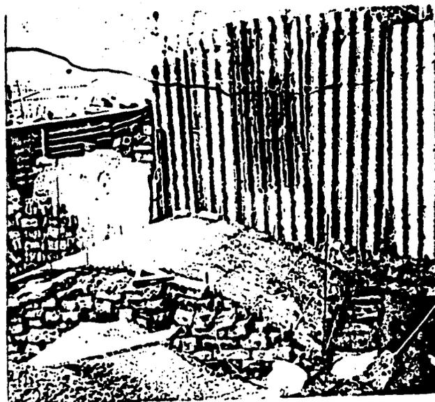
MOLDE HECHO DE TIERRA CON UNA CAPA DE 3 M. DE CONCRETO PARA HACER DOVELAS DE TABIQUE ARMADO.
