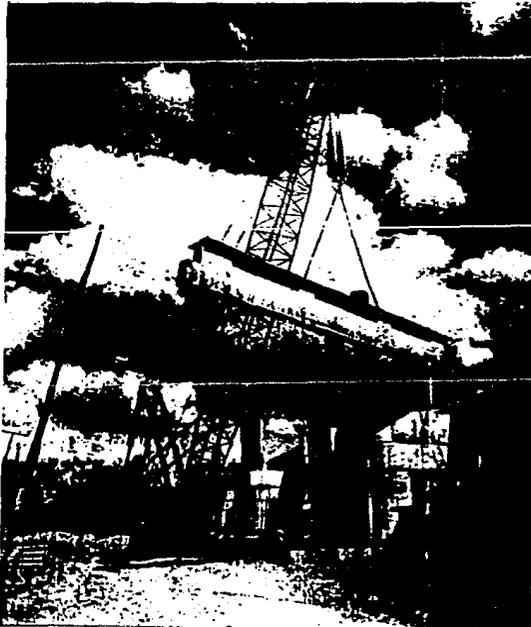
(fig. 4.12) Se observa el montaje de una trabe por medio de una grúa sobre orugas.
