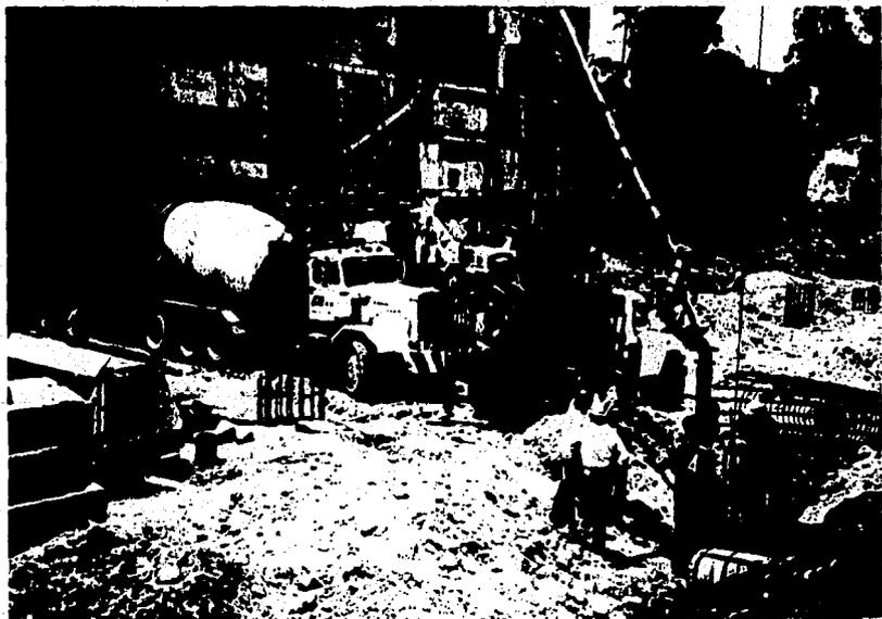
Se debe de tener cuidado en el suministro del concreto, ya que en caso de suspenderse, se formaría una junta fría entre el concreto ya vaciado y el nuevo, motivo por el cual, puede cambiar al resistencia a comprensión de la pila.
