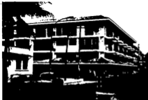
93. Edificio "Pañeda" recién terminado Esq. Calle Allende y Av. M. Ocampo Mtz. de la Torre, Ver. 1980
