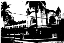
106. Antiquo Banco Nacional de Crédito Ejidal. Fachada a Av. M. Avila Canacho. 1978
