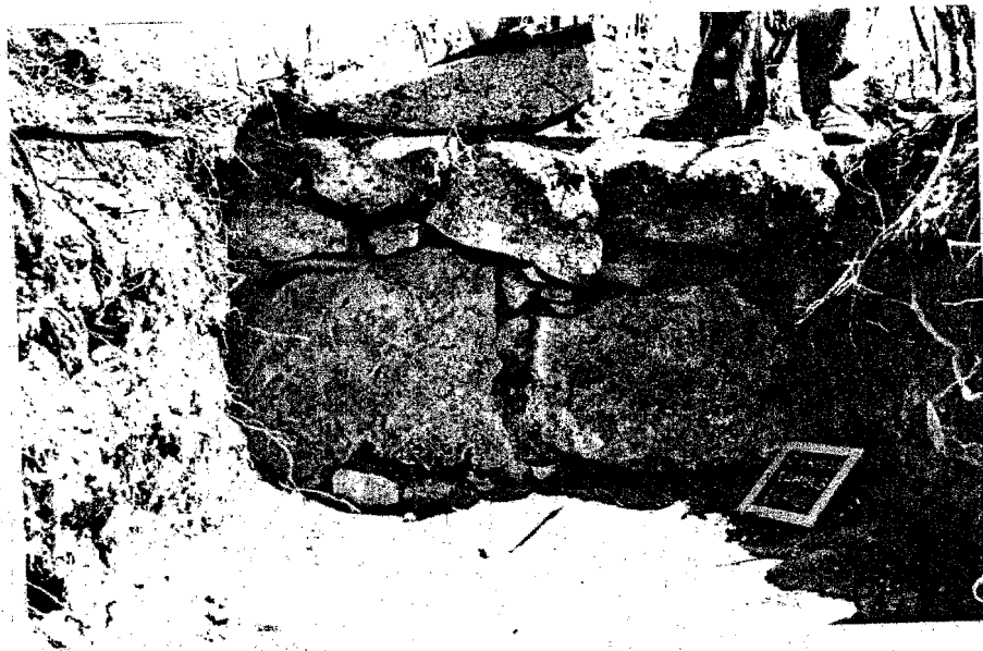
Foto 8. MURO QUE UNIA LOS EDIFICIOS CERRANDO LA PLAZA INTERIOR EN CERRO PRIETO, MEZQUITIC.
