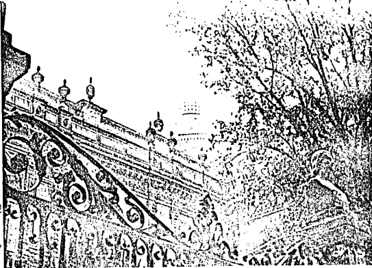
DETALLE DE LA REJA QUE CIERRA EL ALTIPO CON SUS COLUMNAS Y REMATES PERSONAJES.
