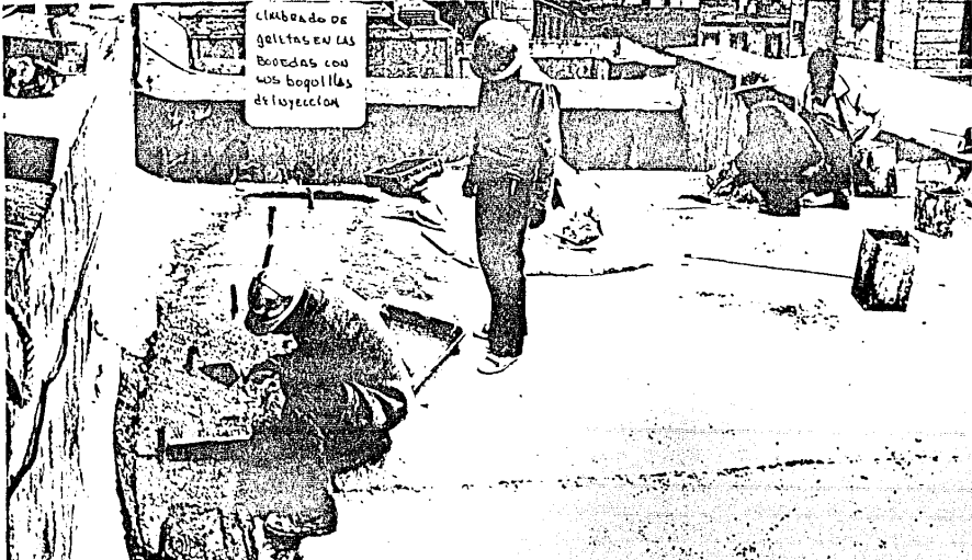
GRIETA EN DOPO DE LOS MUROS DE LAJA PILLAS CEMENTALATERALES YA PREPARADAS CON LOS DOPOILAS ANTES NADA A CERRAR
