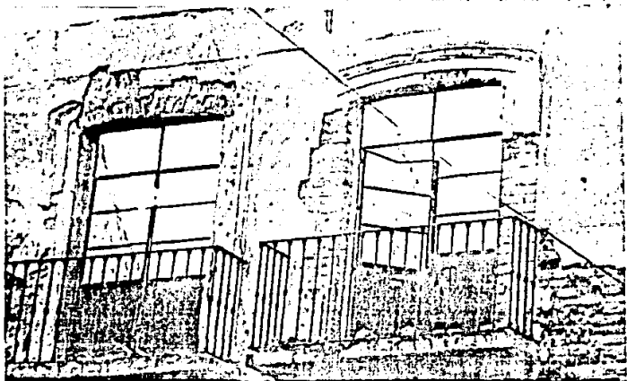
1, 2 y 4, edificios del CENTRO HISTORICO
