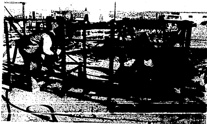
Fabricación de las pirámides "PIÑAS" con la ayuda de un escantillón metálico.
