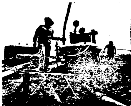
BOMBA ESTACIONARIA FIJA EN ACCION
