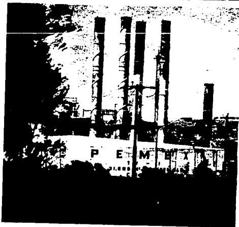
Fig. 4. Refinería en el estado de Hidalgo, con chimeneas.
