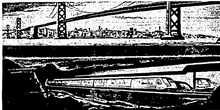
FIG. 5.19. ESTE ES EL PRECURSOR, DE UNA NUEVA GENERACIÓN DE SISTEMAS DE TRÁNSITO URBANO DE ALTA VELOCIDAD. LOS TRENES SE CONTROLAN POR COMPUTADORA Y PUEDEN CORRER A 112 Km/HR. A INTERVALOS DE 90 SEGUNDOS APROX. 6.5 KM. DE ESTE SISTEMA PASAN BAJO EL AGUA POR TÚNELES MUY SEMEJANTES A LOS UTILIZADOS EN EL PUENTE-TÚNEL DE LA BAHÍA DE CHESAPEAKE.
