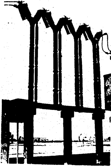
Interrupor de 400 KV
