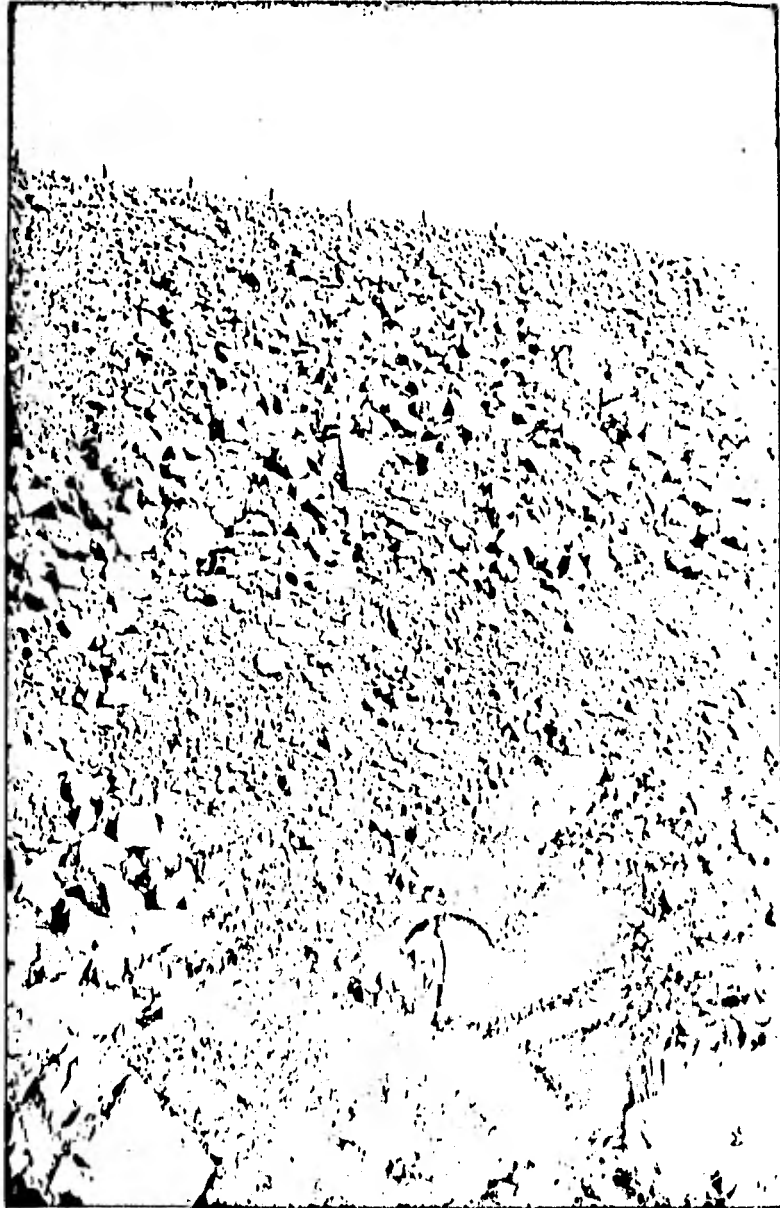
Fig. 54 - Uno de los primeros terraplenes altos (22.55 m) colocado sobre un tubo Multi-Plate de 1,83 m de diámetro, en la carretera de Miami-Superior, Arizona.
