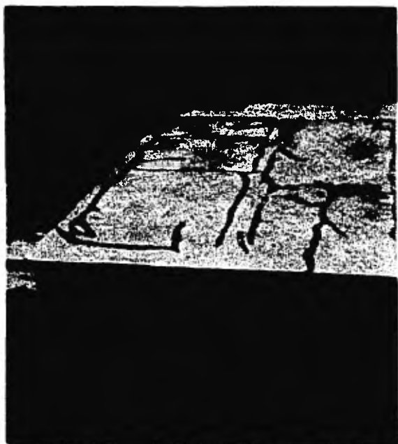
AGRIETAMIENTOS DE LAS LOSAS
