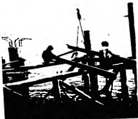
Fig. III.5 Viguetas sobre - los escantillo-- nes.
