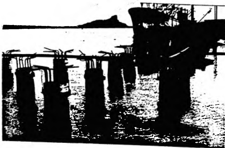
Fig. IV.1 Mordazas colocadas en las pilas.
