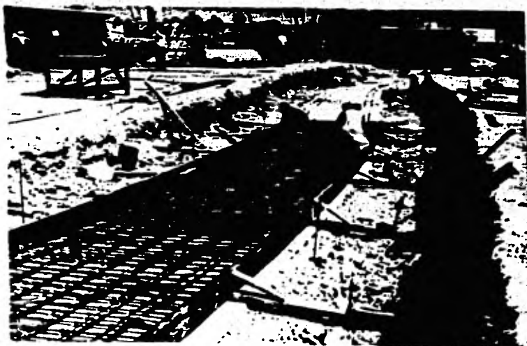
Fig. VI.6 Acero de refuerzo en vías.
