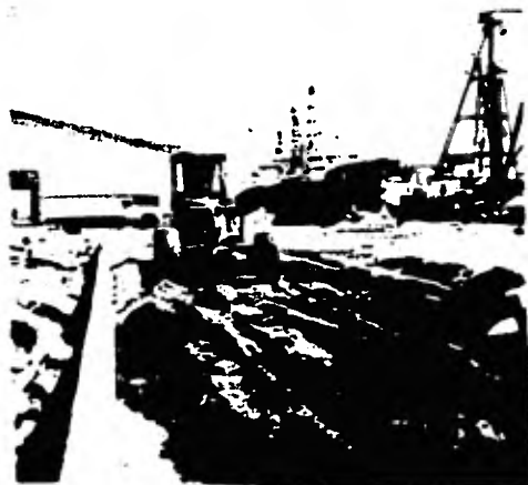
Fig. V.3 Extendiendo el relleno.
