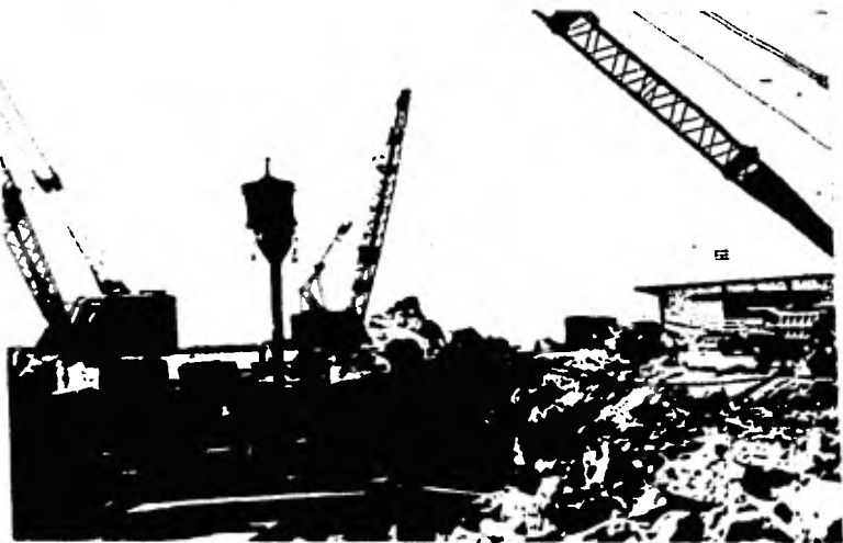
Fig. III.26 Grúa sobre el chalán, colando pilas.
