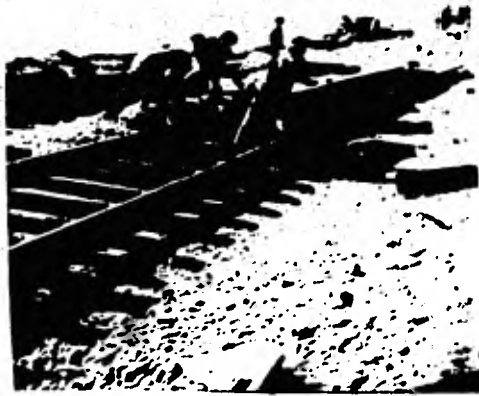
Fig. VI.5 Alineando y alzando las vías.
