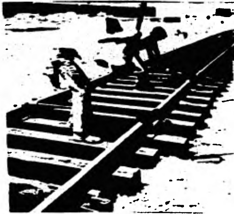
Fig. VI.4 Clavando vías sobre los durmientes.
