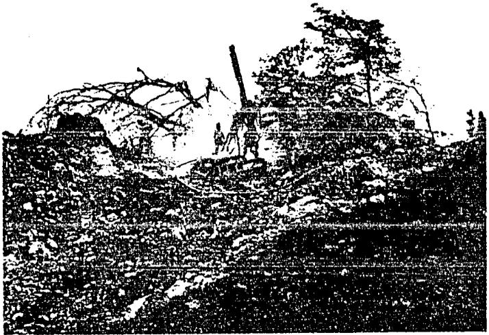
Perforadora sobre tractor "Track-drill",
