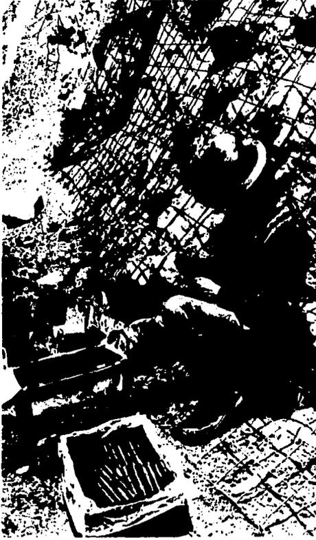
Fig. 20 Uso de las mallas para voladuras.
