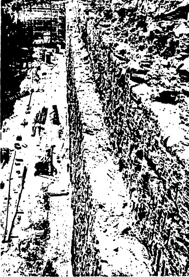
**Fig. 63** Uso del precorte para la excavación de un canal parte-
