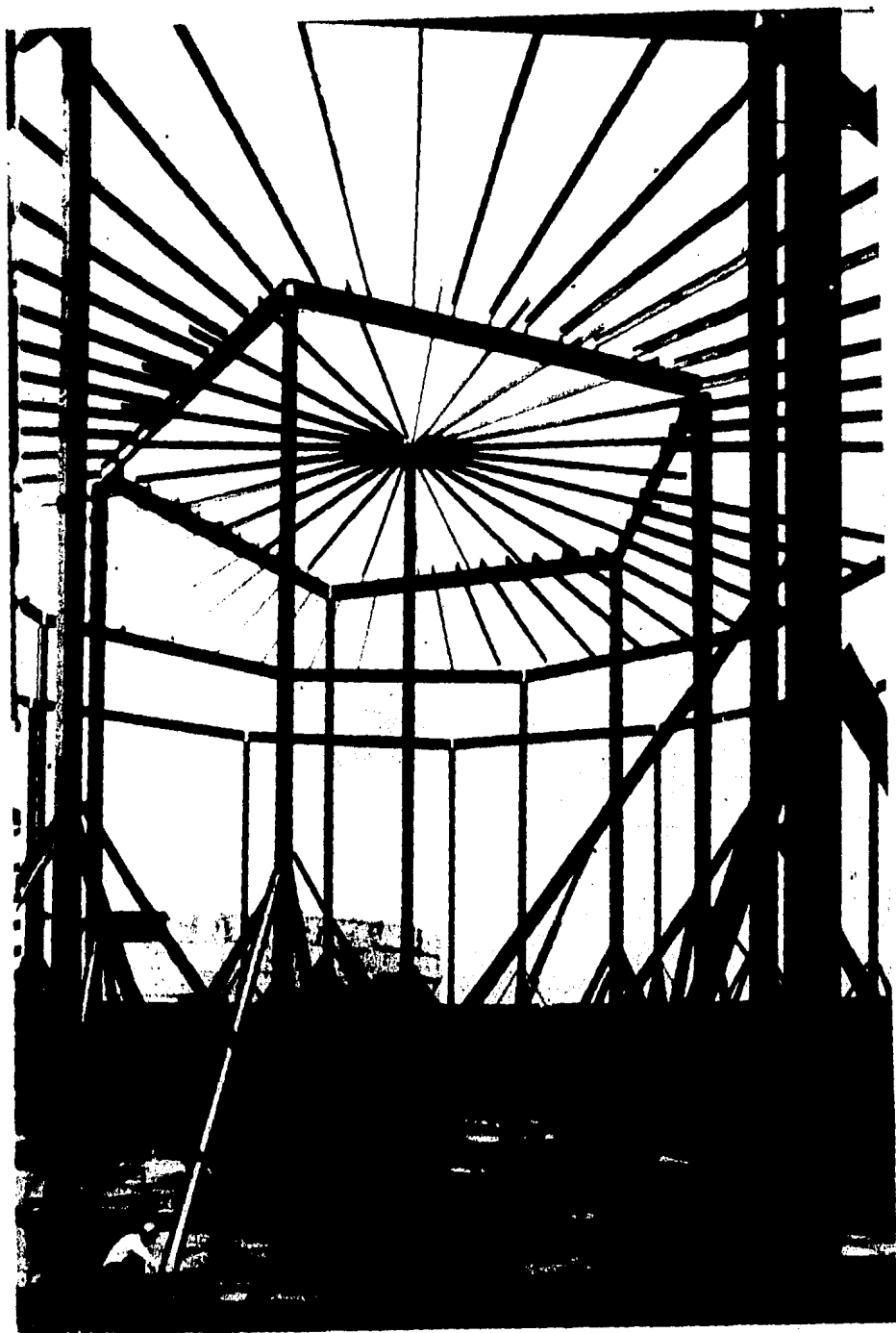
FIG.3.15. VISTA DE LAS COLUMNAS DE LA ESTRUCTURA SOPORTE DE UNA TAPA.
