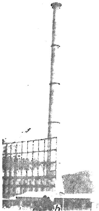
Fig. No. XXXII Chimenea de 220 m. de altura construida con cimbra deslizante.
