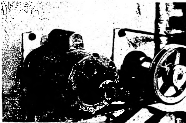
Vista de la Bomba.
