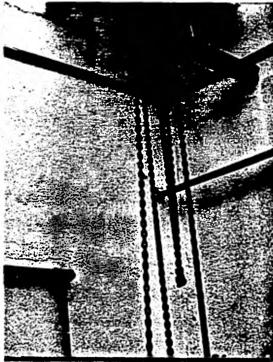
Diferencial de cadena acopla do al puente por medio del trolley.
