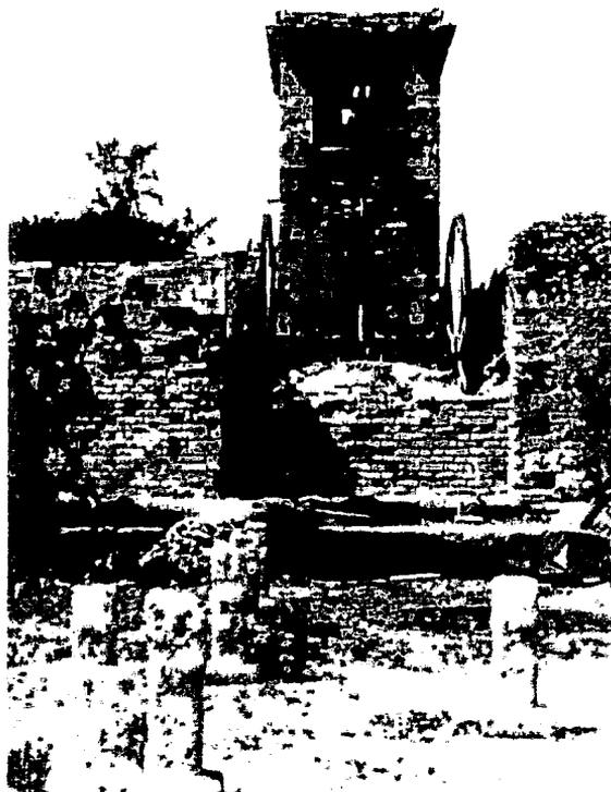
Foto No. 11. Bombas Cornish utilizadas en 1749, para la extracción de agua de la mina actualmente se encuentran aún en los patios de la Hacienda Proaño.
