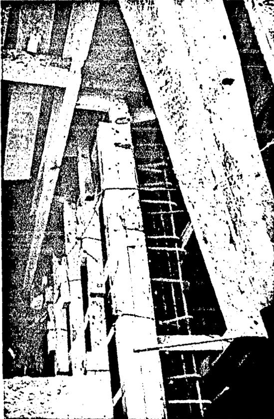
FOTO 3.-Armado y cimbrado del muro de atraque.
