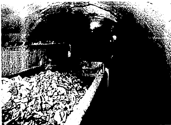
Desalojo de material - utilizando convoys.
