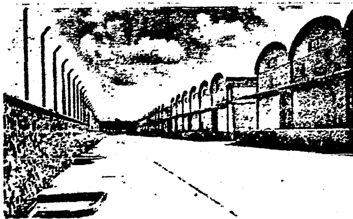
Aspecto exterior de las bodegas planas, sin ninguna mecanización, lo que dificulta mucho el manejo de los granos y semillas, agudizando el problema de la conservación
