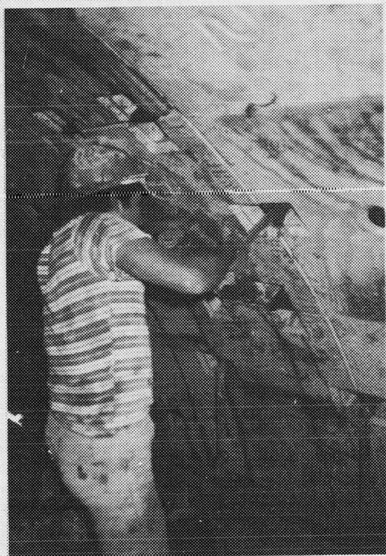
FIG. III-20 APRETAR TORNILLOS ENTRE SEGMENTOS.
