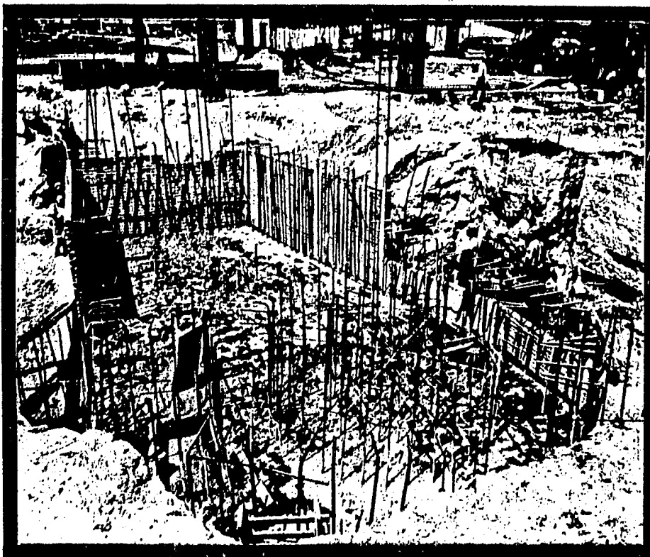
COLADO DE CIMENTACION DEL TORNO VERTICAL
