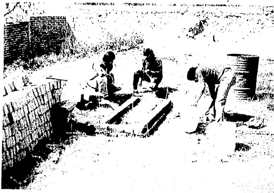
3. Al planear la base, se colocan los ladrillos dejando una separación razonable entre uno y otro, ya que éstos son de tamaño diferente.
