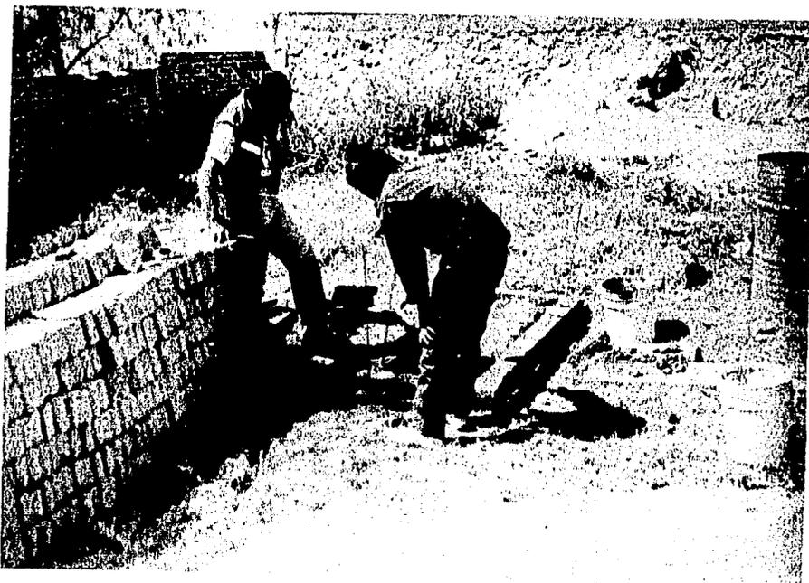
2. Marcar la altura del fogón, utilizando una manquera con agua, de tal manera que tengan una construcción uniforme.
