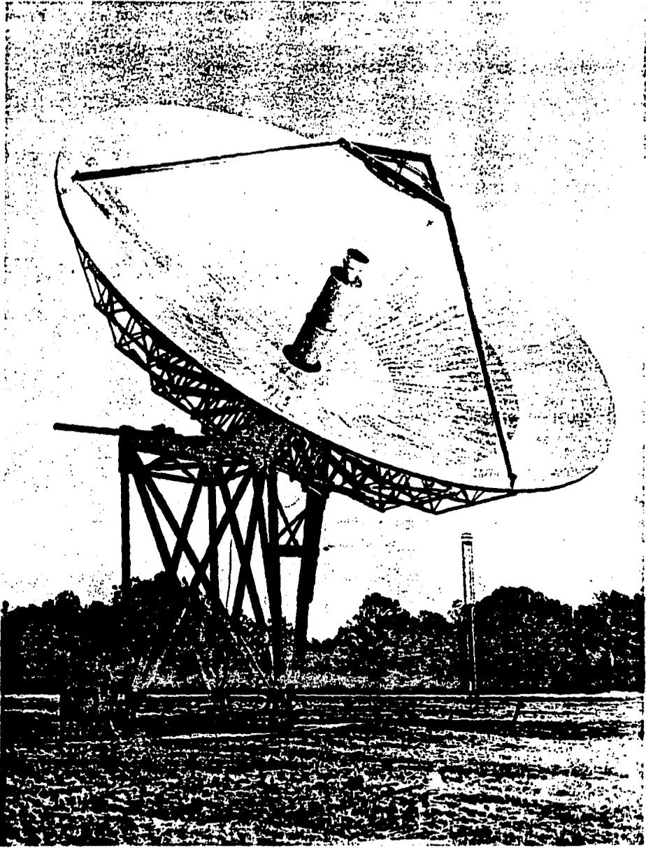
Fig. 2.4. Antena de 11 metros de diámetro para estaciones terrenas estándar B de INTELSAT.
