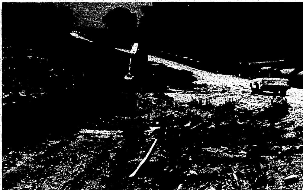
Excavación de zanja con retroescavadora Caterpillar 235.
