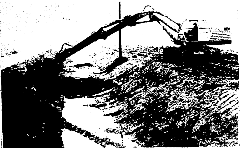
RETROEXCAVADORA RECTIFICANDO UN CANAL CON BOTE NORMAL.
