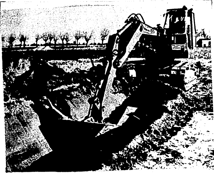
RETROEXCAVADORA CONSTRUYENDO UN CANAL CON BOTE TRAPEZOIDAL.
