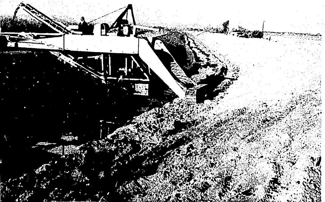
DOS MODELOS DIFERENTES DE ZANJADORAS DENOMINADAS MAQUINAS CANALERAS CUANDO ESTAN EQUIPADAS PARA LA CONSTRUCCION DE CANALES.
