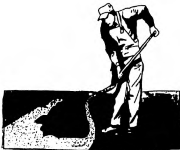
10.10.3 APLICANDO AGREGADO DE CUBIERTA.
