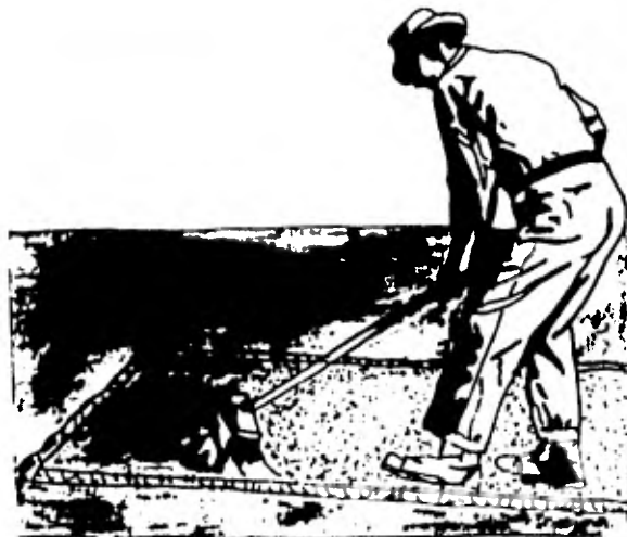
10.1 BARRIENDO LA MEZCLA DE PLANTA SOBRE GRIETAS DE PIEL DE COCO- DRILO.
