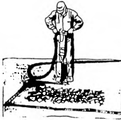
10.1 CORTANDO LA CARA VERTICAL ALREDEDOR DE LA ZONA AGREGADA
