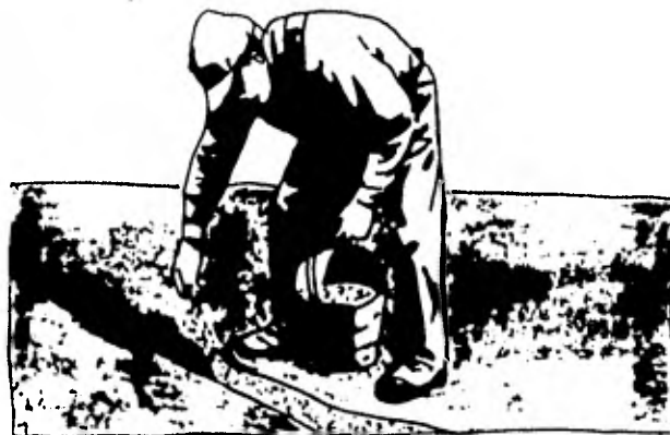
4.3 ESPARCIENDO ARENA SECA EN LA SUPERFICIE
