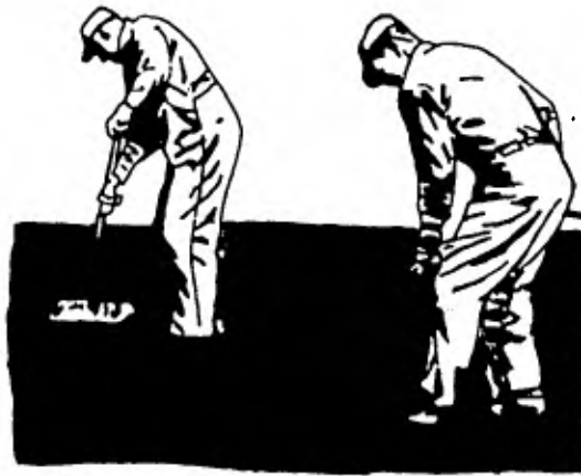
10,5 LIMPIAR LA GRIETA CON ESCOBA Y AIRE
