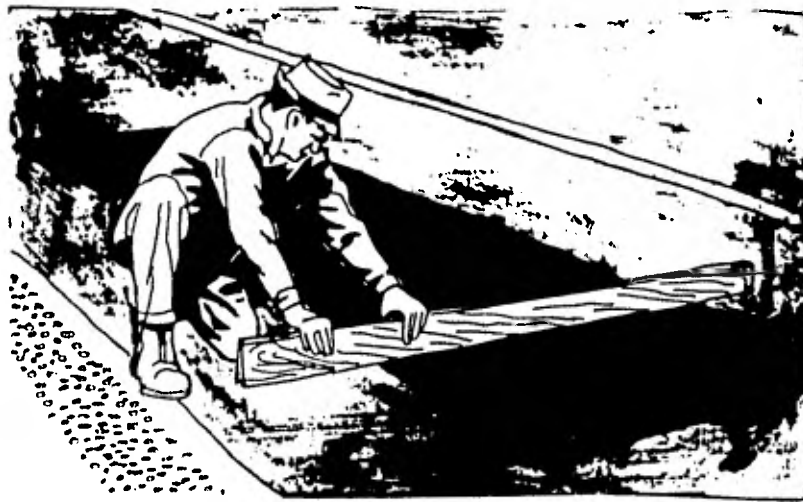
10.1 RECORRIENDO EL BACHE CON LA REGLA DE MA- DERA.
