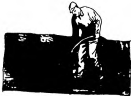
10.8 SOPLETEANDO LAS JUNTAS.
