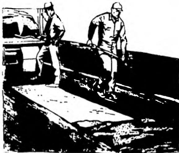
10.10 RELLENANDO EL AGUJERO CON MEZCLA DE PLANTA.
