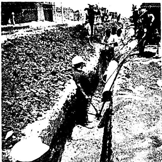
Bajada de las tuberías de alcantarillado.
