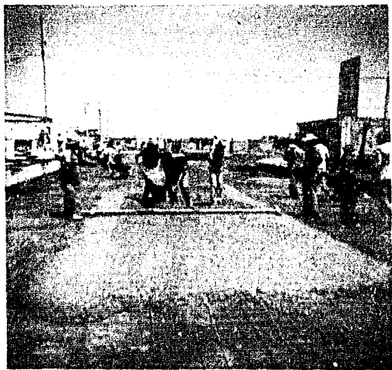
Construcción de losa estabilizadora armada con malla-lack.
