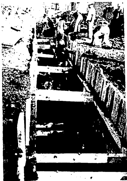
Cepa para drenaje con ademe de madera
