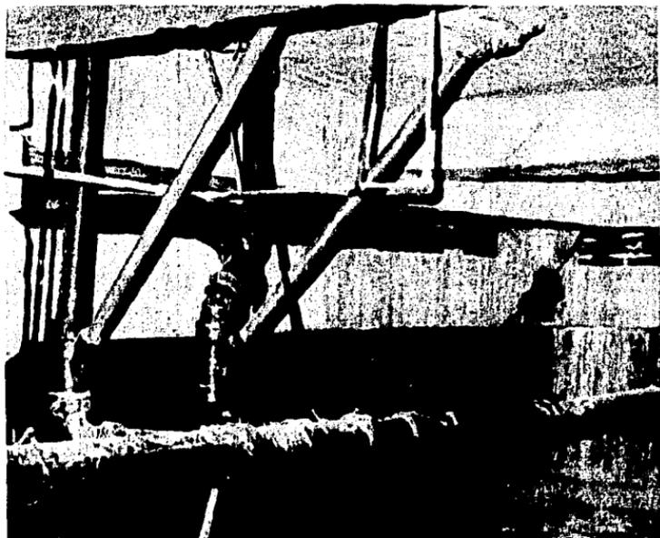
FOTOGRAFIA 6. Se aprecia como las instalaciones sanitarias y de otros tipos cuelgan de la estructura del edificio, que se moverá junto con él mismo.
