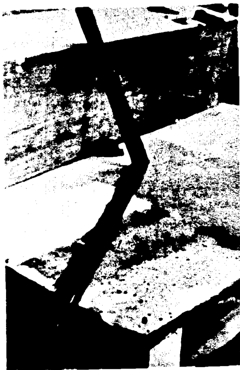
Perfil utilizado a manera de de "cinturón" para efectuar las uniones externas de las primeras tres etapas
