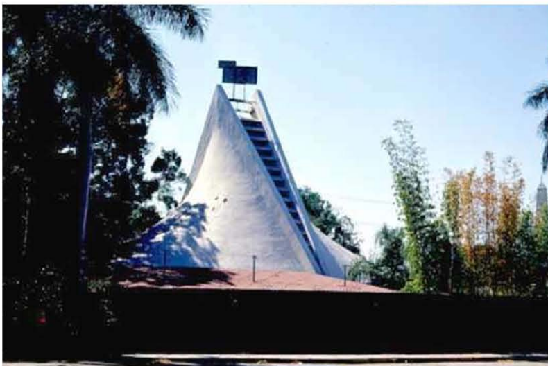
La Discoteca Mambo vista desde el exterior del Casino de la Selva. Imagen: Structurae, Internacional Database and Gallery of Structures, ver URL en el índice de referencias. Reproducción con fines didácticos.
