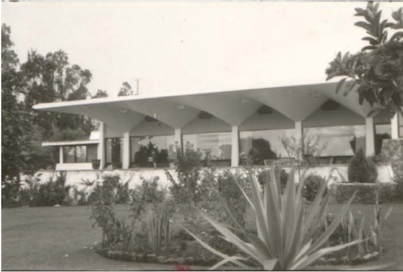
Exterior de la casa Abaunza, se pueden apreciar los paraguas que componen la fachada Fotografía: Juan Antonio Tonda. Reproducción con fines didácticos.
