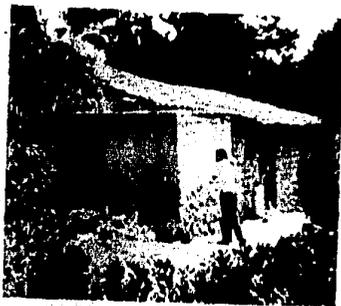
LAS CONSTRUCCIONES DE LAS ZONAS MAS ANTIGUAS DEL LUGAR, SE CARACTERIZAN POR QUE SUS MUROS (MACIZOS) FUNCIONAN COMO MUROS DE CARGA, SUS MATERIALES SON TRADICIONALES (PIEDRA Y ADOBE), LOS MACIZOS TIENEN UN ESPESOR DE 30-40 CM, Y UN PESO CONSIDERABLE, EL GROSOR DEL MURO RESPONDE A LA NECESIDAD QUE SE TIENE DE CONTAR CON UN AISLAMIENTO TERMICO, QUE MANTENGA UNA TEMPERATURA CONSTANTE AL INTERIOR DE LA VIVIENDA.
