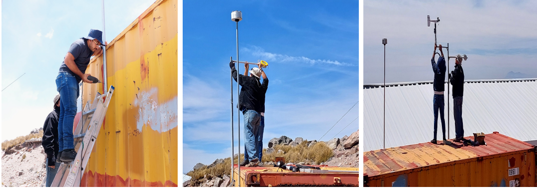
Figura 3.4: Trabajo de campo realizado para la instalación de los sensores meteorológicos en el ORC-SN. De izquierda a derecha: fijación de los tubos de soporte, colocación del piranómetro, colocación del anemómetro.
