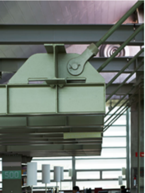
Imagen 34. Detalle estructural. Taller de Arquitectura X / Alberto Kalach
