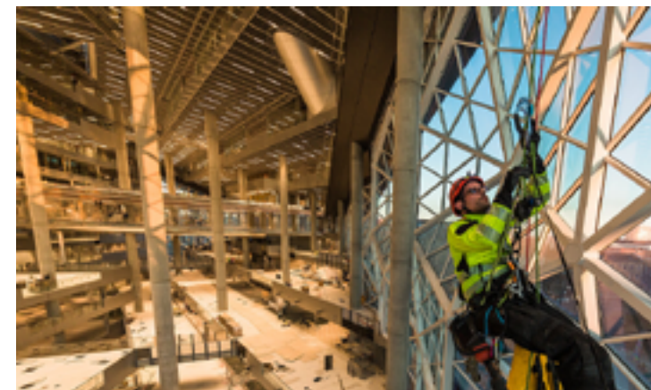
Imagen 59. Fotografía de proceso construcción. Laurian Ghinitoiu
