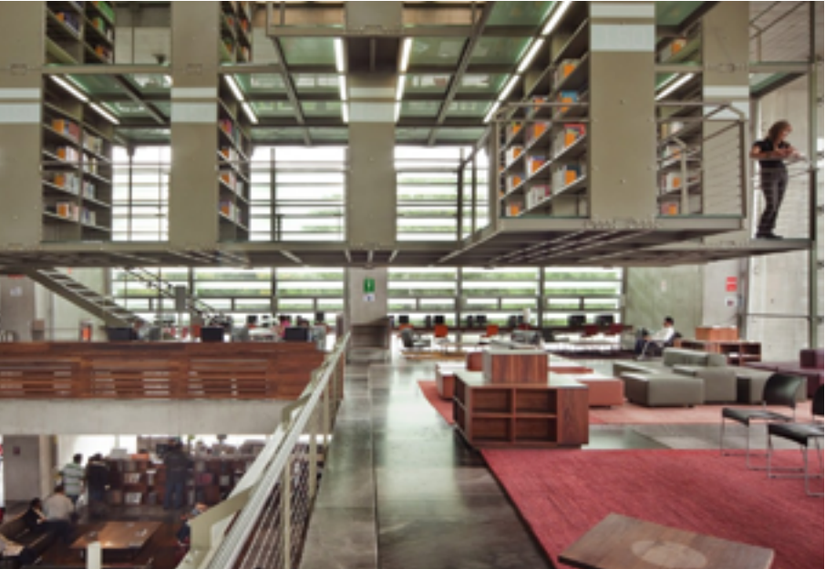
Imagen 35. Espacio de consulta dentro de la biblioteca. Taller de Arquitectura X / Alberto Kalach
