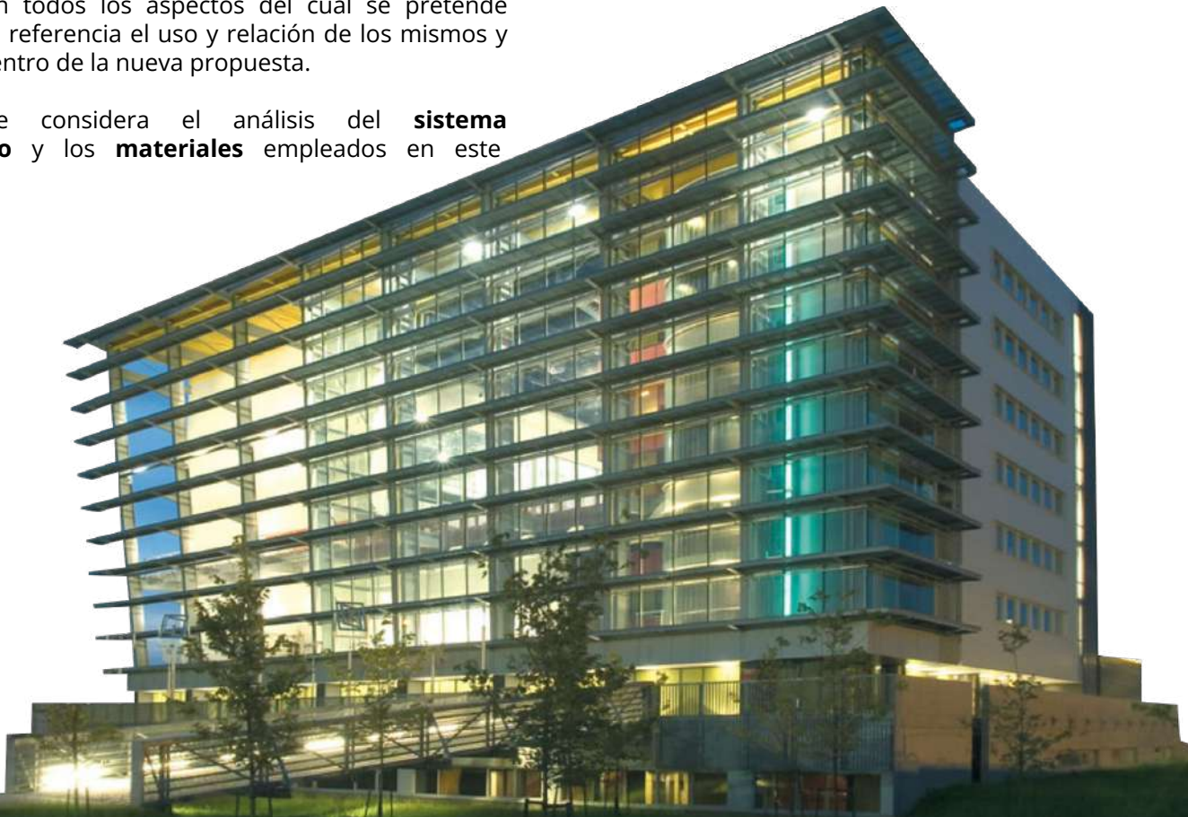
Imagen 140. Fachada Principal de Escuela Nacional de Circo en Montreal, Canadá.
