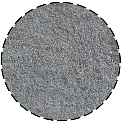
CONCRETO EN BRUTO
