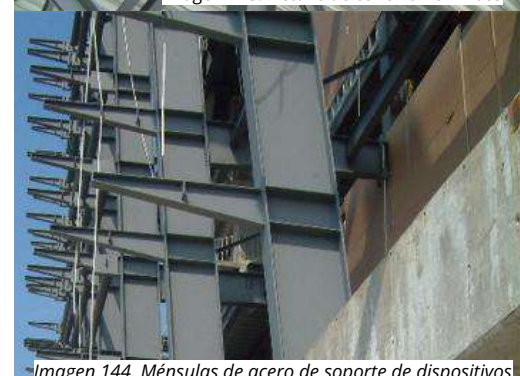
Imagen 144. Ménsulas de acero de soporte de dispositivos
