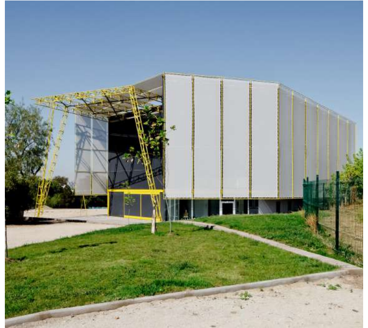
Imagen 135. Fachada Centro de las Artes Aéreas.
