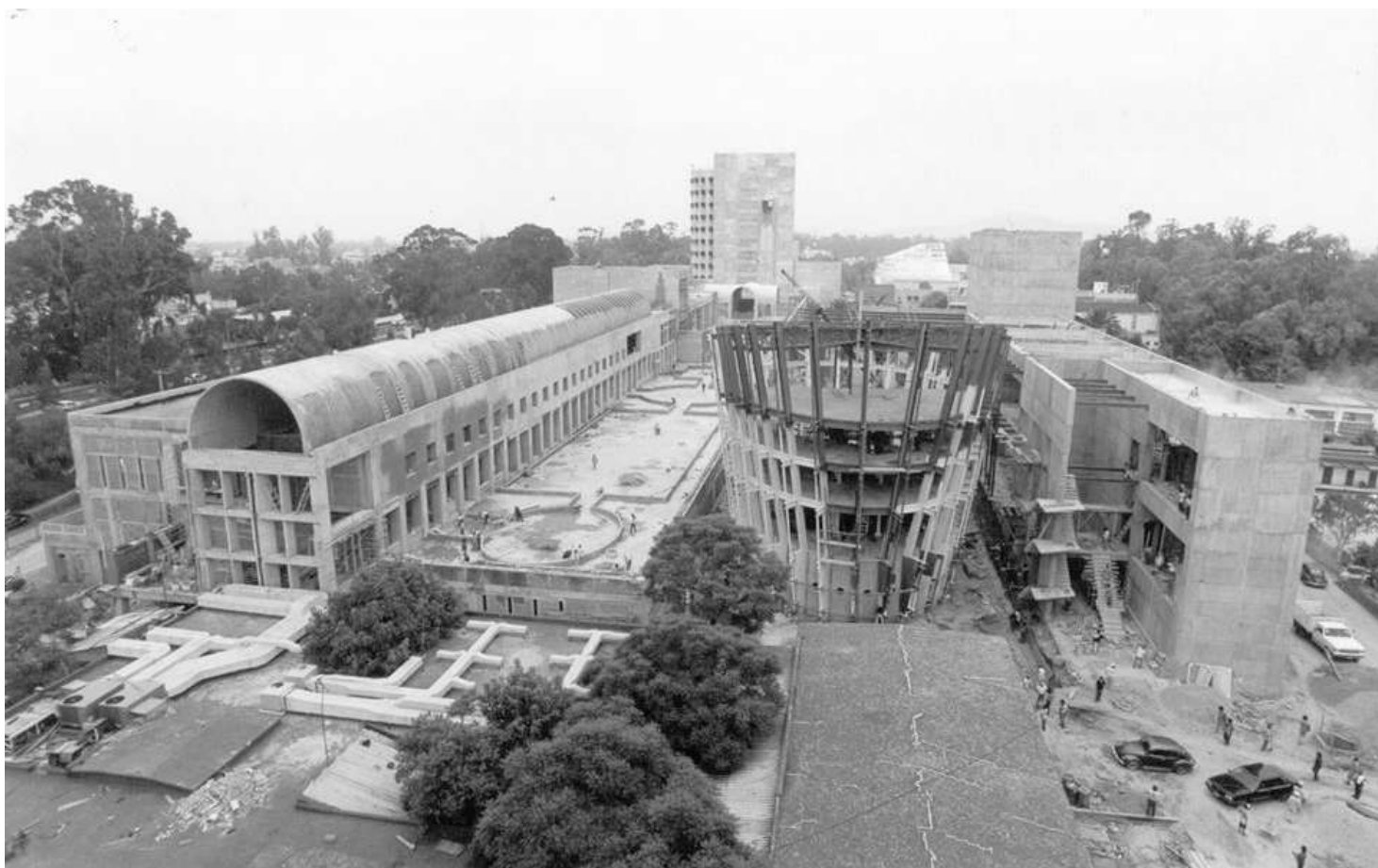
Imagen 37. El CENART en construcción.
