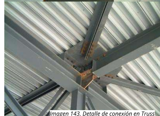
Imagen 143. Detalle de conexión en Truss
