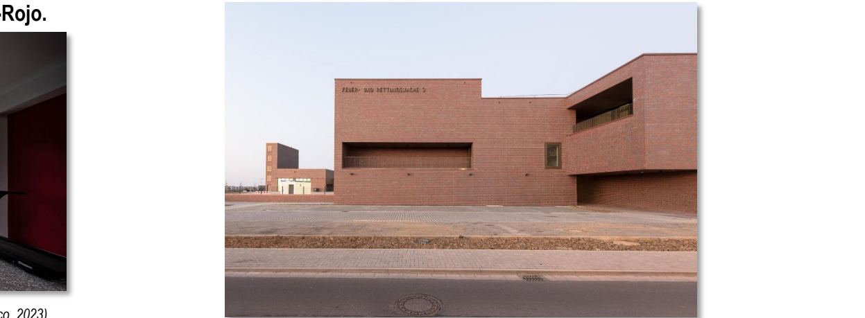
Imagen 22. Fachada de la Estación de Bomberos y Rescate Wiesbaden-Igstadt. (Archdaily México, 2022)
