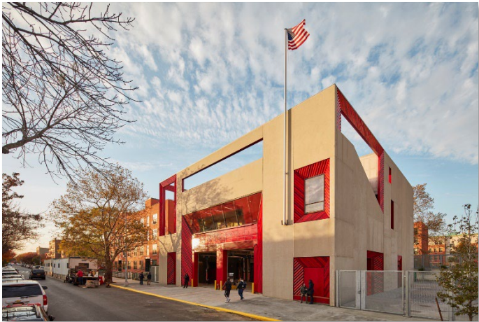
Imagen 30. Formas Ortogonales en la Fachada de la Instalación de la Compañía de Rescate 2 del FDNY. (Archdaily México, 2022)
