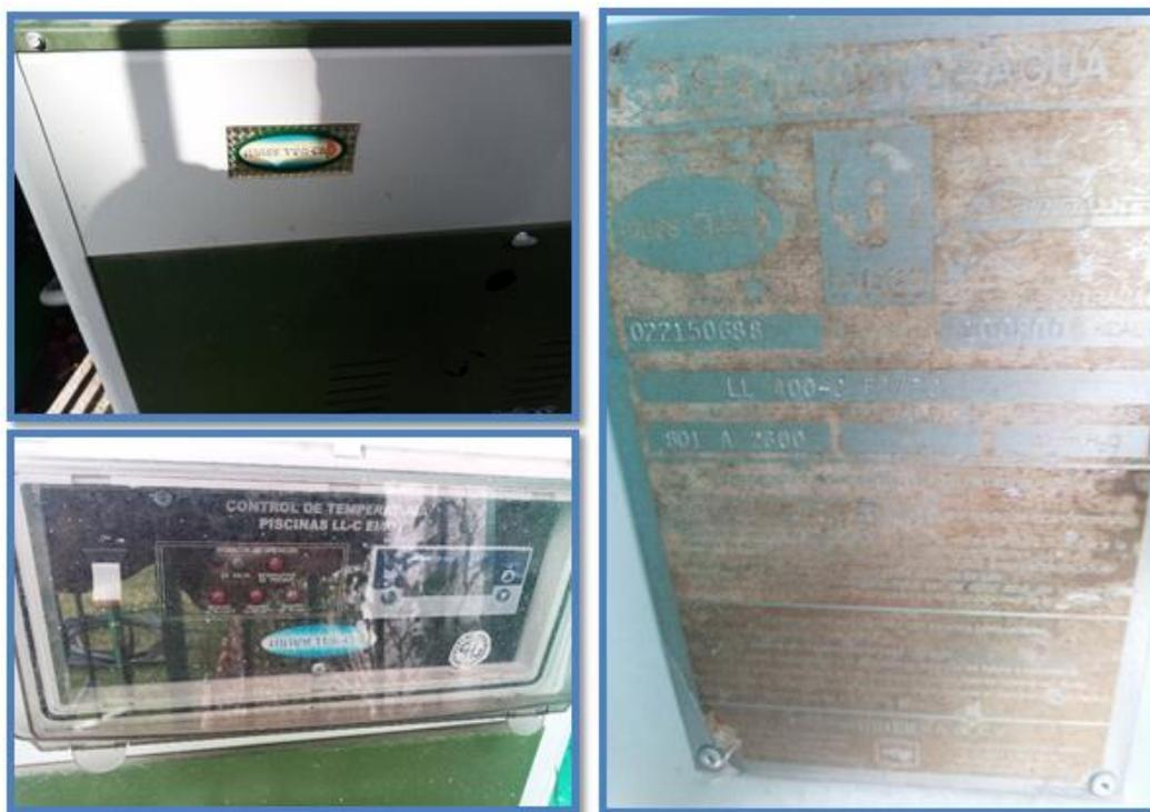
*Figura 4 Generador de Calor, control y datos de placa de Casa Andrea.*
