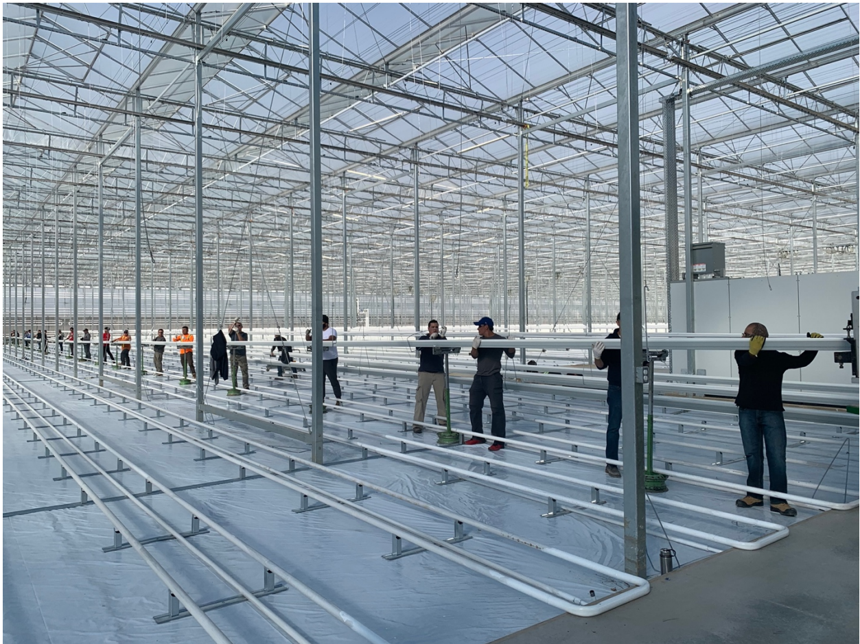
Fotografía 3. Construcción de nuevo invernadero en Leamington, Ontario (Canadá)
