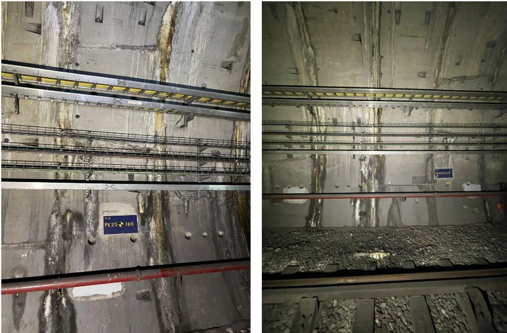
*Figura 4.2. Filtraciones observadas en el revestimiento (dovelas).*
