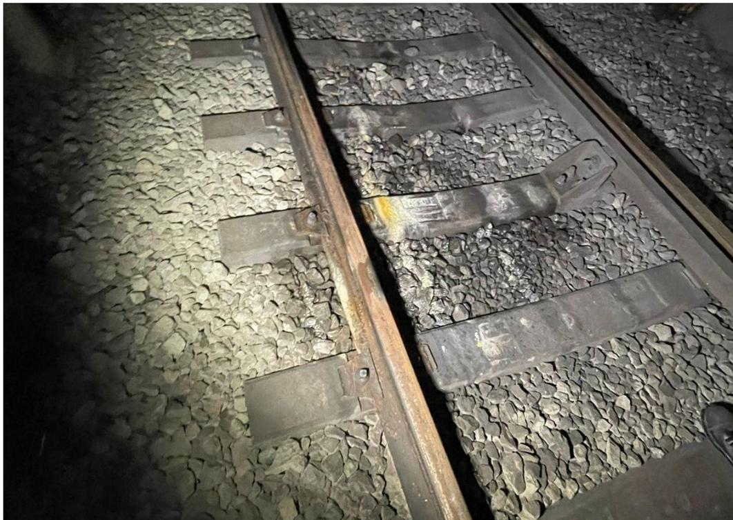
*Figura 4.3. Acumulación de sales sobre un durmiende causado por las filtraciones.*
