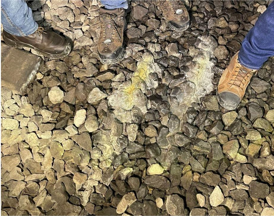
*Figura 4.4. Generación de sulfatos sobre el balasto causado por la presencia constante de agua en esta zona.*
