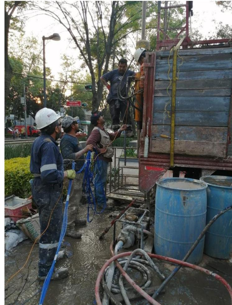
Figura 4.21. Instalación de la estación piezométrica PZ-02, ubicada en el tramo Parque de los venados - Eje central.
