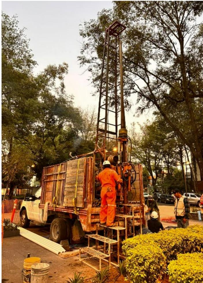
Figura 4.20. Instalación de la estación piezométrica PZ-01, ubicada en el tramo Zapata - Parque de los venados.
